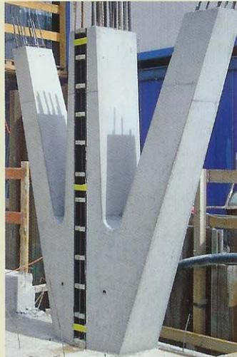
▲ W-Stütze mit Sonderschalung aus dem Doka-Fertigservice.
